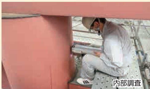
袴鉄板部分を剥がし調査
