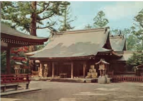
昭和43年頃の銅板葺き後の社殿『旧略記』より
